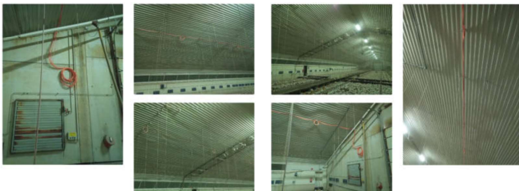
Abbildung 16 Vorbereitung der Installation der Kamera
